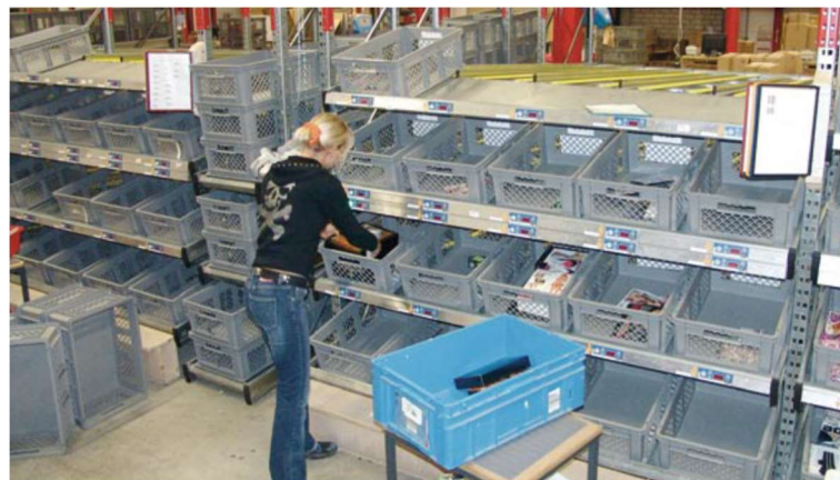
In der neuen Durchlaufregalanlage mit Pick-by-Light-Funktionalität kann ein Auftrag auf bis zu 36 Kanälen gleichzeitig kommissioniert werden. Pro Kanal sind bis zu 6 Behälter möglich.
